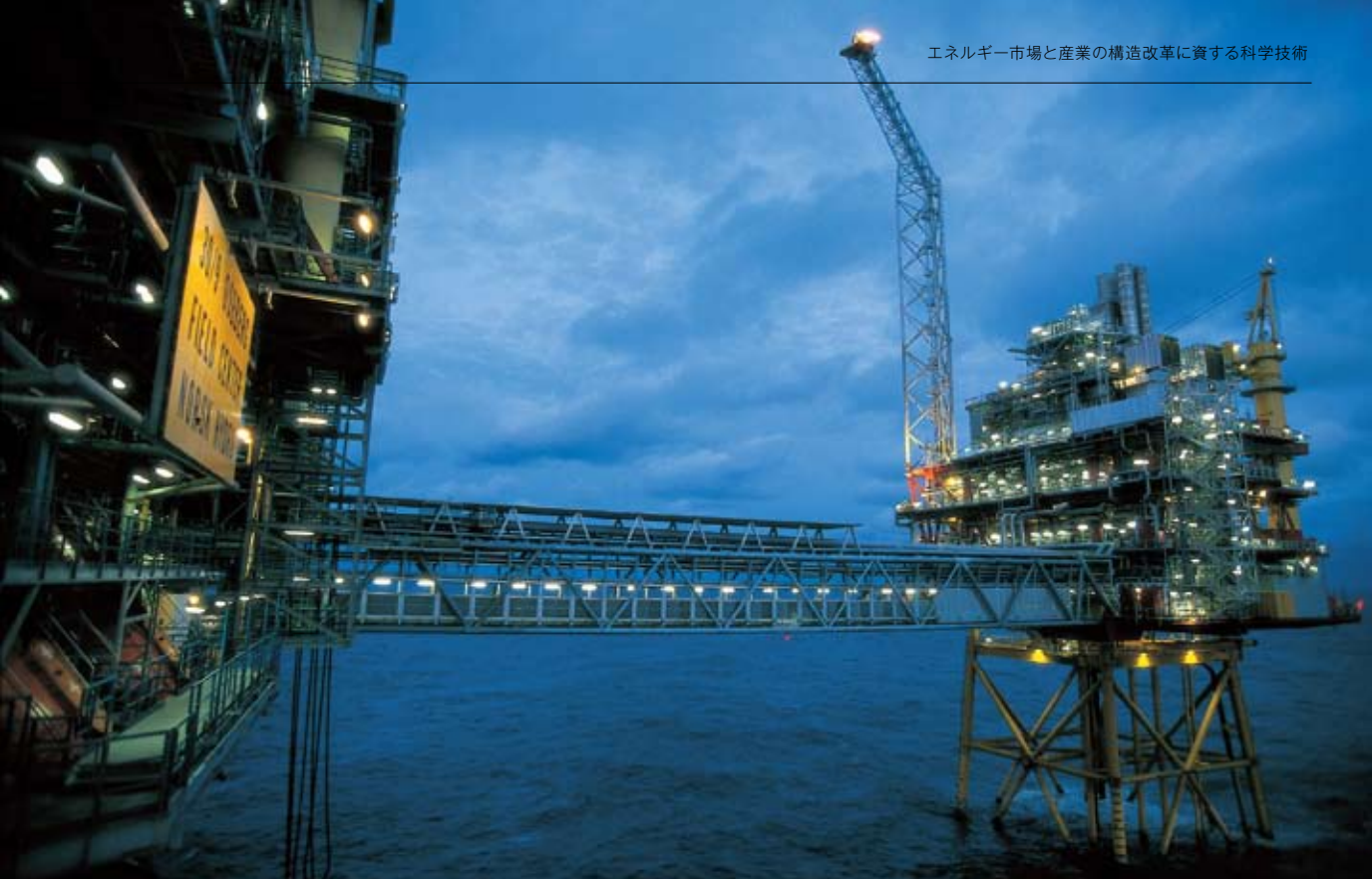
北海油田・スライプナー西鉱区では、ノルウェーの石油・ガス会社が世界で初めて、商業規模のCO 2 回収・貯蔵事業を行っている。大規模な洋上設備(右)で天然ガス中のCO 2 を回収し、1日2800トンを深さ1000メートルの海底帯水層に注入している。
